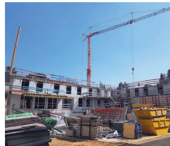
In Ludwigsburg an der Königsallee schreiten die Bauarbeiten voran.
